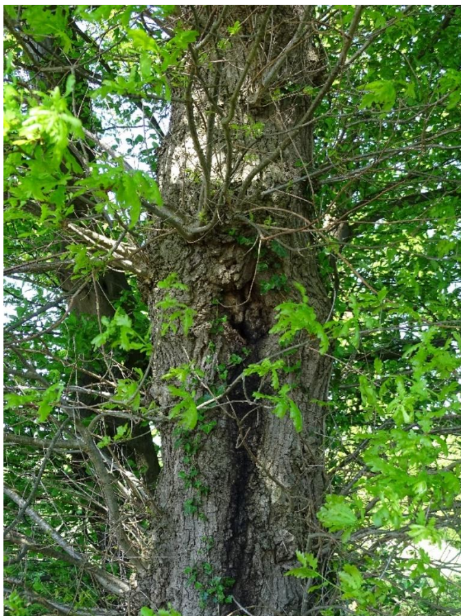
Abb. 4: Astabbruchstelle mit kleiner Höhlenbildung an einer Eiche mit rund 60 cm Stammdurchmesser an der Straße ‚Zum Hohen Moor‘ im Osten des Bbauungsplangebiets (07.05.2018).
